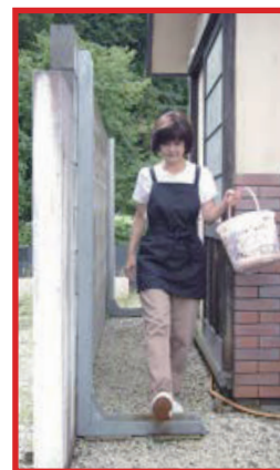
■FITパワー 取り付け後も住人は通ることが可能です。 ※通常、L字部分は地中に埋設されます。(下記図参照)
