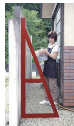
■従来の金属支柱 取り付け後、住人は通ることに窮屈さを感じます。
